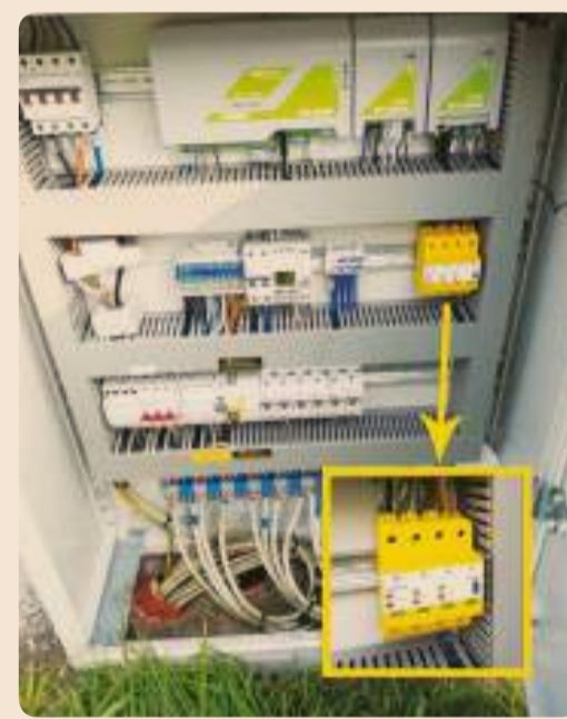
Esempio di installazione di uno scaricatore ZOTUP in un quadro elettrico
