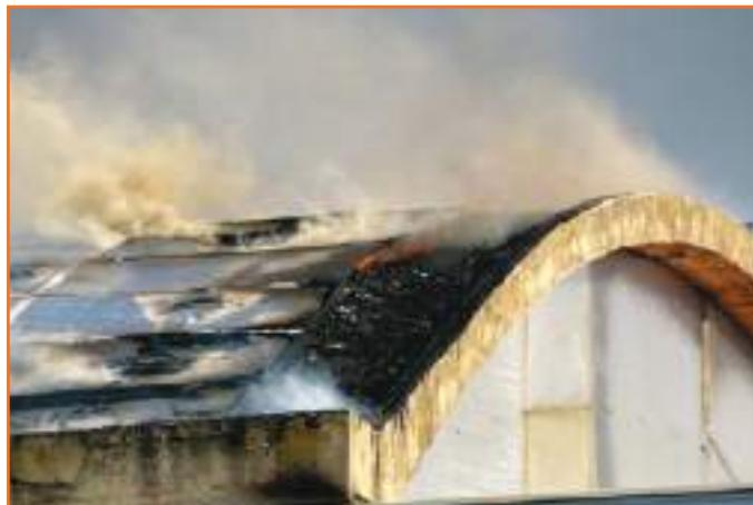
Fig. 9 - Propagazione dell'incendio dai moduli fotovoltaici all'interno dell'edificio.
