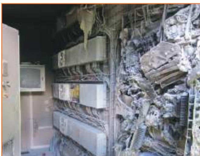
Fig. 4 - Incendio di un impianto fotovoltaico.
