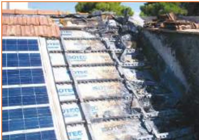
Fig. 2 - Incendio di un impianto fotovoltaico.
